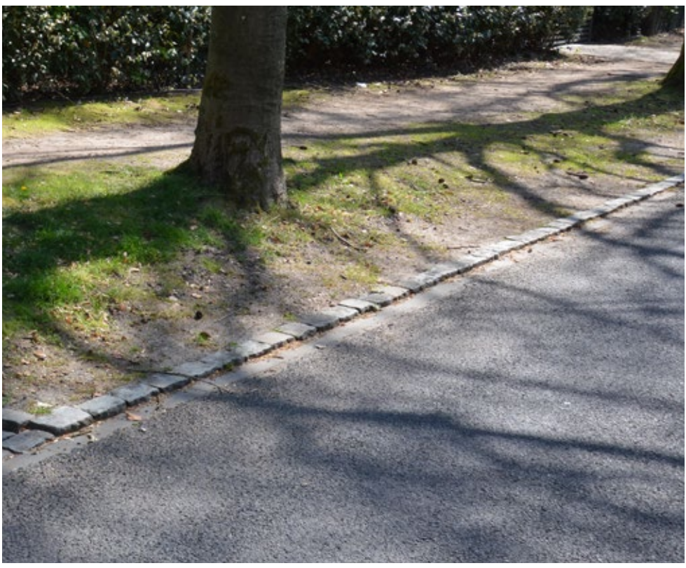
De strook melafierkeien (natuursteen) vormt een doorlopende lijn. De strook wordt niet onderbroken.
