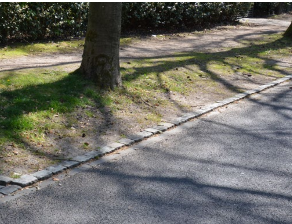
De strook melafierkeien (natuursteen) vormt een doorlopende lijn. De strook wordt niet onderbroken.
